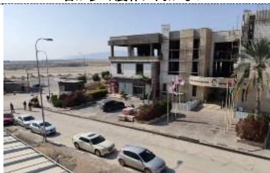
写真 4 : JAIP 管理棟増築工事の様子
