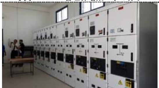
写真 6 : JAIP 専用変電所内高圧分岐パネル
