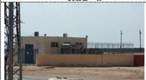
写真 7 : JAIP 専用変電所外景 右側はポンプ施設
