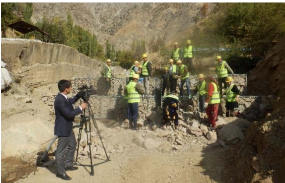
Съемка участка строительства
