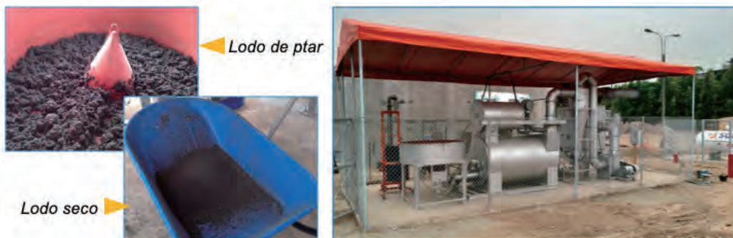
Planta piloto (Ptar Santa Clara)
