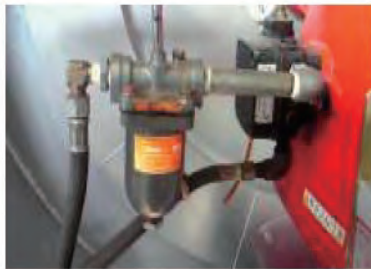
(Limpieza del filtro combustible.)
