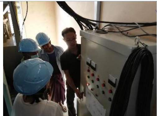
据付した機材の説明および試運転（2019年11月22日、タンボジセンター、ニャウンシュエ）
