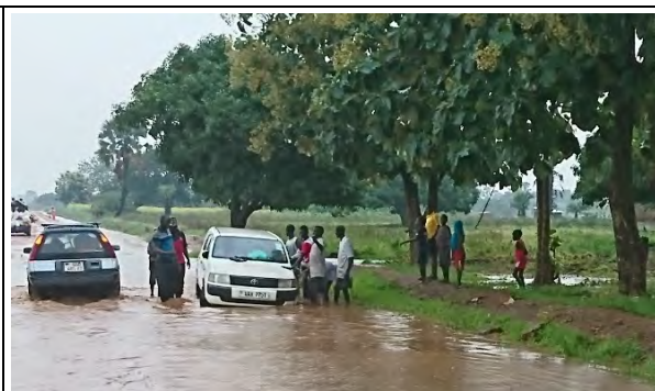
国道 (B 級国道、本プロジェクト対象) (ユンベ ーウレ橋) 雨季に道路が冠水し、車両がスタックしている。
