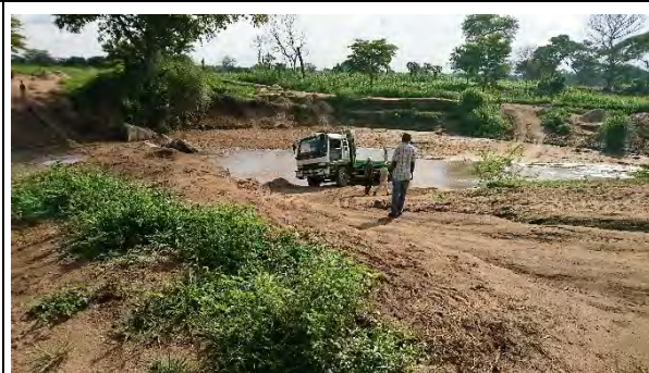
新コロ橋架橋位置 河床渡河を試みたトラックが川でスタックしている。
