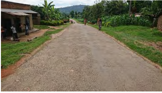
8年前に実技で施工したマカダムシール舗装
