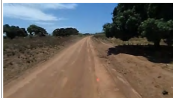
支線道路（フィーダー道路2、本プロジェクト対象外）（国道・ゾーン1側） 路面は比較的良好である。
