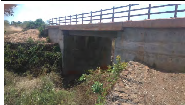
ウレ橋 (本プロジェクト対象外) 雨季、乾季ともに河川水量が少ない。
