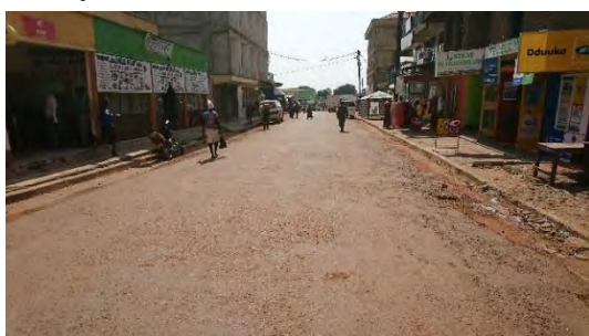
アルア市内のシール舗装道路 1
