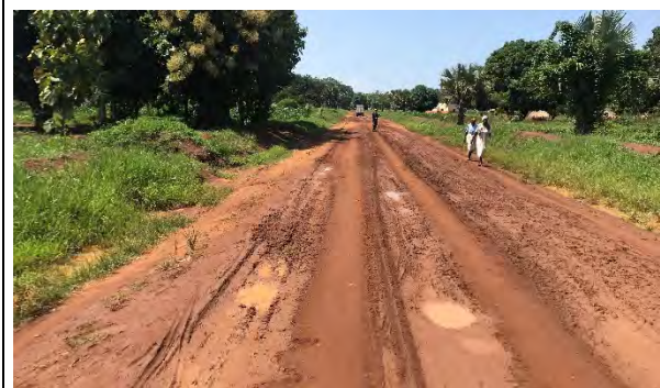
国道 (B 級国道、本プロジェクト対象) (ユンベ ーウレ橋) 未舗装であることから、降雨後に車両が通行する と道路路面が乱れる。
