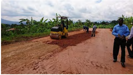
小型機材による路盤の転圧
