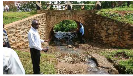
LBTの実技指導で実施したコンクリートアーチ橋
