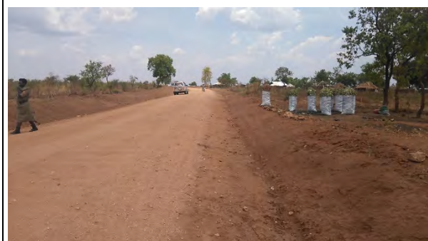
補助幹線国道（C級国道、本プロジェクト対象外） （ロコーオボンギ、ゾーン4） 路面は比較的良好である。
