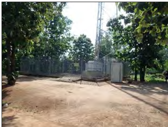
図 2-2.6 携帯電話用鉄塔 （国道（B級国道））
