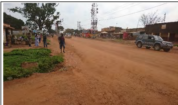
国道 (B 級国道、本プロジェクト対象) (ユンベ ーウレ橋) ユンベタウン：乾季の路面状況は比較的良好である。
