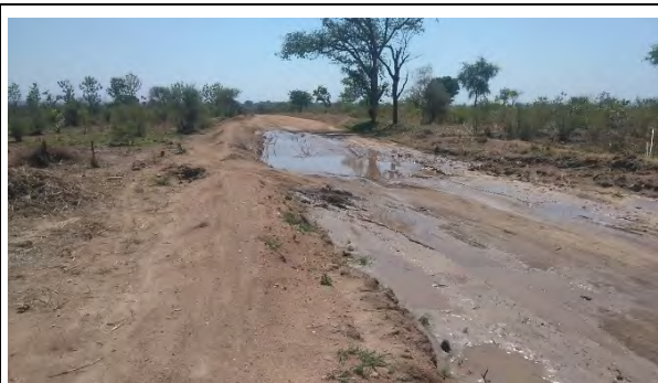
支線道路（フィーダー道路1、本プロジェクト対象）（国道・ベースキャンプ手前） サグ部で水が溜まり、路面状況が非常に悪い。
