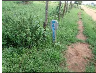
図 2-2.4 ドナーにより敷設された水道管（支線道路（フィーダー道路1））
