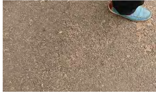
マカダムシール舗装（拡大）
