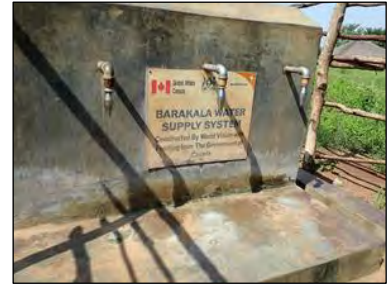
図 2-2.5 ドナーにより敷設された水道（支線道路（フィーダー道路1））
