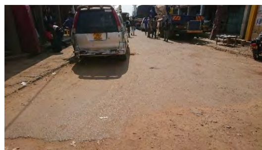
アルア市内のシール舗装道路 2
