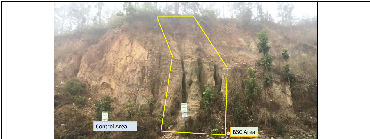
(1) BSC 工法実施 6 か月後の Demo-1 (2020 年 1 月 20 日)
