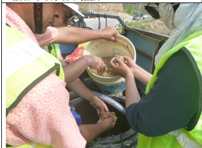
タンク内への柔らかくしたファイバーの投入 (2019年6月13日撮影)
