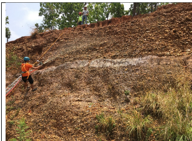
ロープ足場を使った BSC-1 の吹付 (Demo-2) (2019年6月14日撮影)
