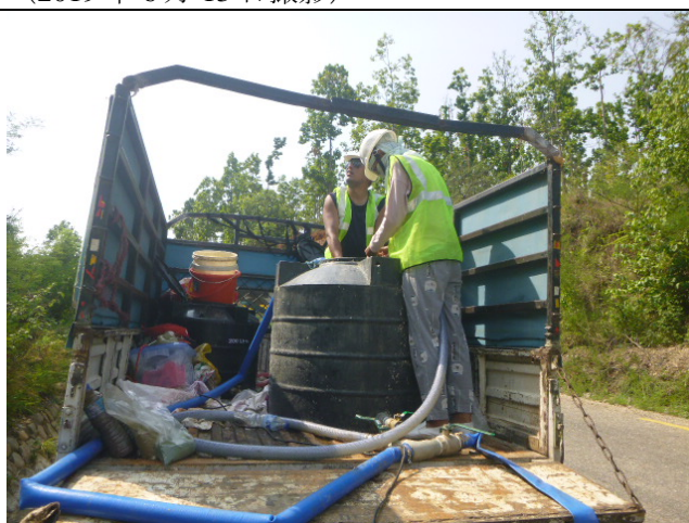
タンク内での資材の攪拌作業 (2019年6月14日撮影)
