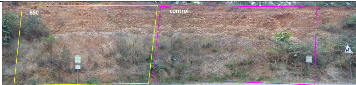
(2) BSC 工法実施 6 か月後の Demo-2 (2019 年 12 月 12 日)
