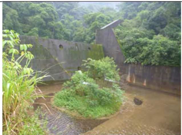
B-5 砂防堰堤(下流より)
