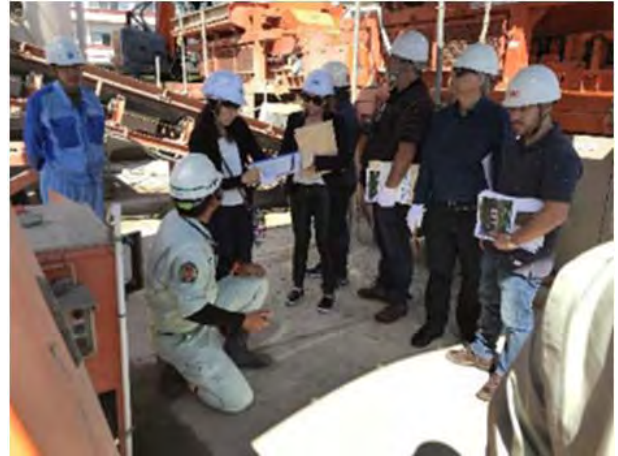
ソイルセメントプラント
