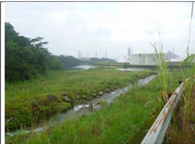
W-10 堆砂地施設
