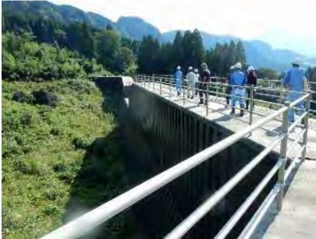
竣工済 ソイルセメント砂防堰堤見学
