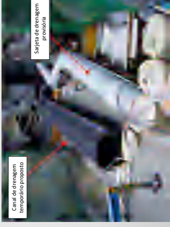
Exemplo da obra de desvio pelo canal de drenagem temporário e pela calha corrugada
