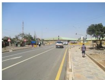
ルサカ南部地域居住環境改善計画 で整備された道路
