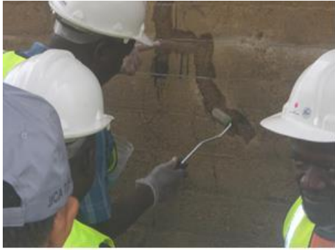
ひび割れ塗布補修
