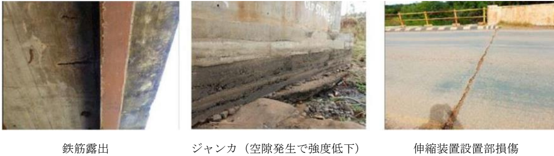
図 2-3-4 調査橋梁損傷状況 (JICA 調査団撮影)
