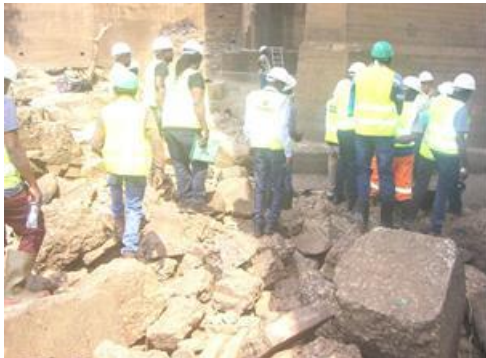
橋梁下は落石で足場が悪い
