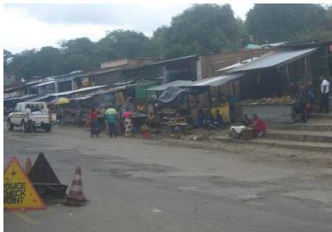
幹線道路は所々陥没し通行に支障が生じている
