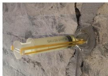
⑤アルファテック 340 注入シリンダー設置
