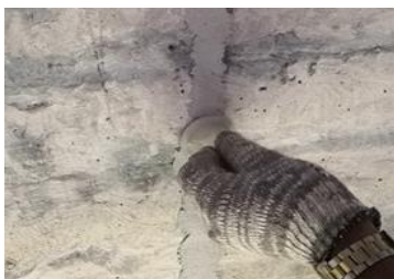
④シリンダー台座設置
