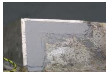
アルファテック 841 水中補修
