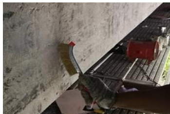
ひび割れ面清掃
