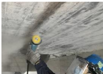
① 剥離部をグラインダーカット
