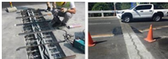
図 2-2-5 伸縮装置交換 (受注者社内資料より)
