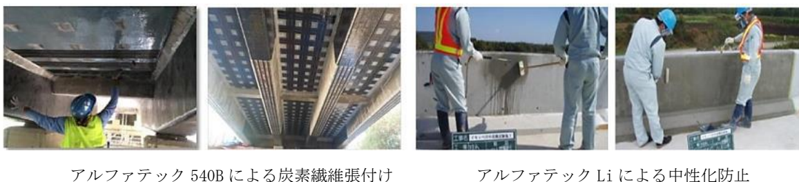
図 2-2-4 桁・床版補修事例 (受注者社内資料より)
