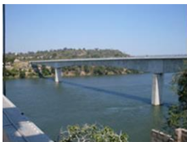
チルンド橋建設計画 橋長 400m ザンビアとジンバブエとを結ぶ橋梁
