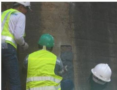
剥離パッチング補修
