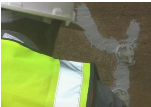
ひび割れ注入補修
