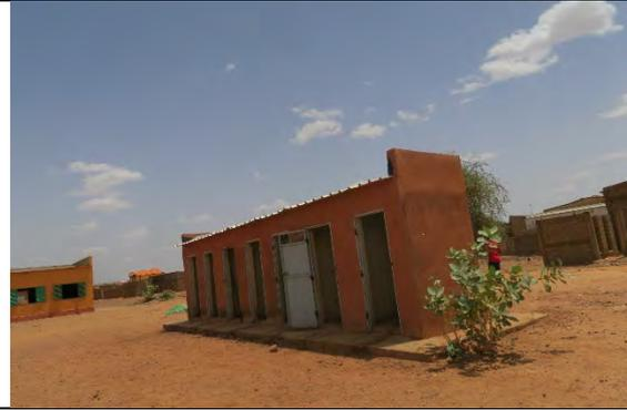
C3 Nimnin de Simiyiri : Les portes du bloc de latrines de 7 cabines pour élèves sont détériorées de sorte que l'intérieur de cabines est apparent.
