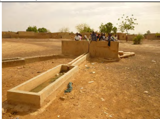
C1 Polesgo 校：大きな雨水貯水タンクが 2 基あるが現在使われていない。
