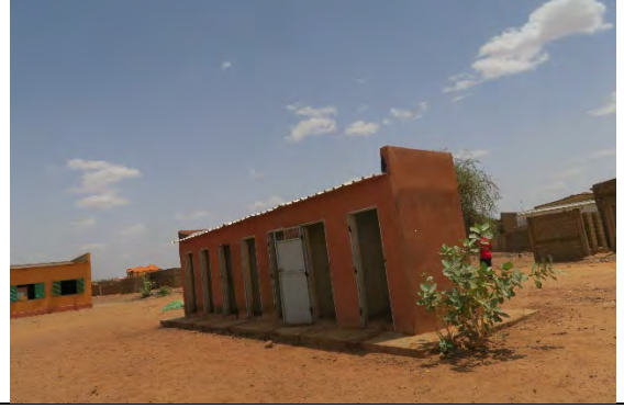
C3 Nimnin de Simiyiri 校：生徒用の7ブース便所棟は、扉が壊れておりブース内がむき出しの状態。
