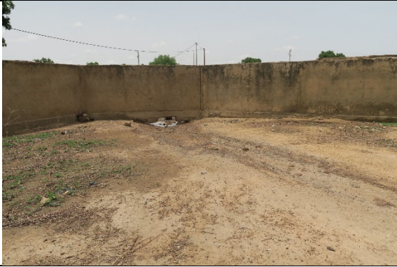
T2 Ngbangré 校：敷地を囲む塀の下部には雨期の為の水抜き穴が確保されている。
