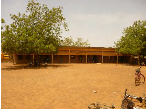
C5 Sig-Noghin 校：敷地内に電気は来ているが、電化は小学校のみで間借り校舎には配電されていない。
