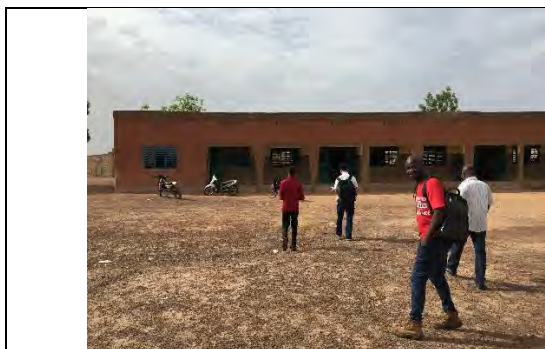
C1 Polesgo 校：最寄りの CEG は 5~6km 離れたところに位置している。
