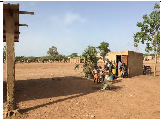
C7 Zongo 校：技術科併設校候補だったが、電力供給がないため、普通校とすることとなった。
