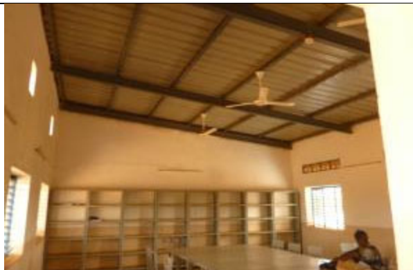
第一次中学校建設計画による管理棟多目的室。教員用の会議室として使用されている模様。
