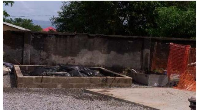
写真：大型焼却炉が援助供与されていたがメンテナンスができず使用不可能となり（左）、ホットゾーンとコールドゾーンで分けた（オレンジのネット）感染性廃棄物の屋外焼却区画（右）を造って対応されていた。（2015 年 10 月当時）（提案法人撮影）
