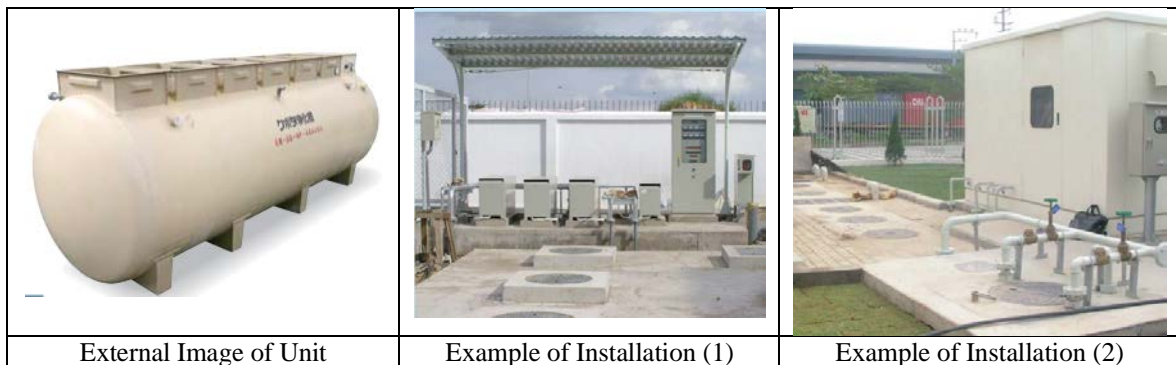
図 8.4.6 浄化槽概略図 (窒素・リン除去タイプ)
