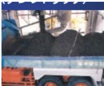
Фото 10-2 Загрузка бетона в самосвал
