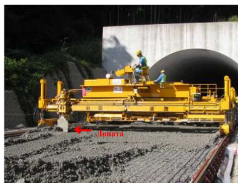
Бетонораспределитель (тип распределения лопастями)
