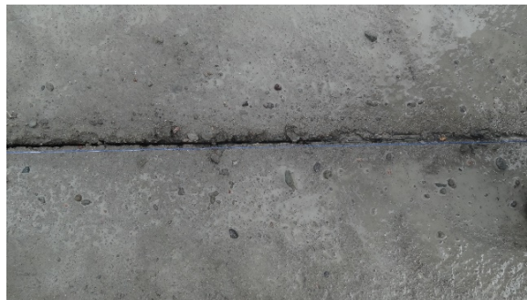
Фото 10-15 Проведение вырезки швов
