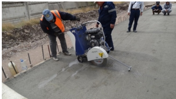
Фото 10-15 Проведение вырезки швов
