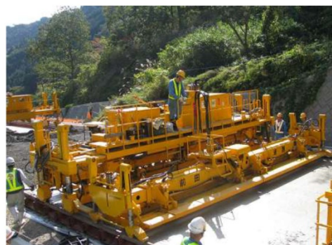
Бетоноукладчик (уплотнение внутренней вибрацией)
