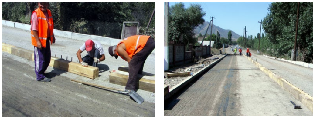
Фото 10-6 Состояние установки опалубки 2010года, 2010
