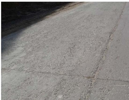
RCC（転圧コンクリート舗装用コンクリート）のコンシステンシー悪化（乾燥しすぎ）
