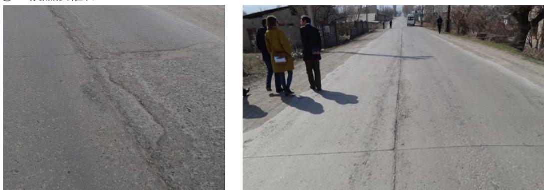
縦方向継目：先行レーンの型枠際の損傷
