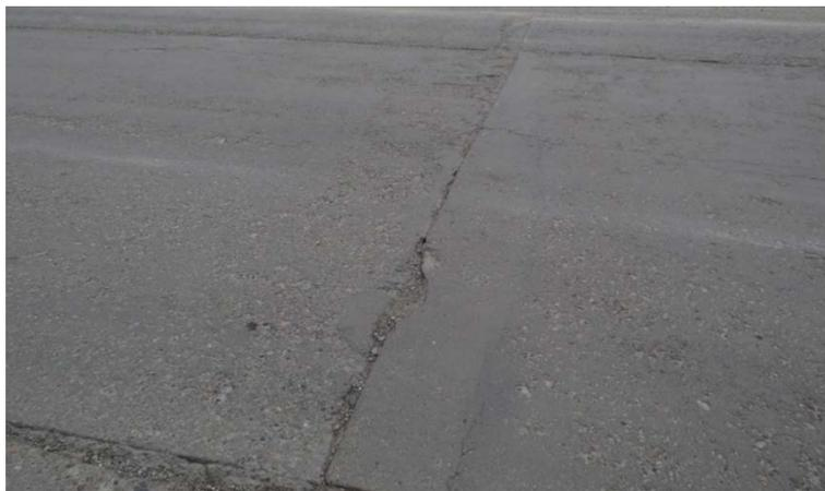
品質不良のRCCを舗設し、供用後、ひび割れ・表面飛散を生じ、部分的に打ち替えている。RCC荷下ろし基準の徹底が必要である。
