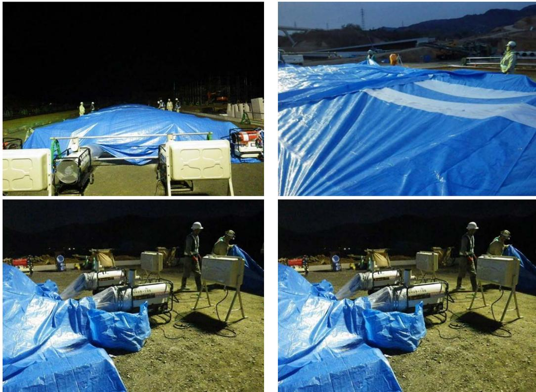
写真 10-14 熱硬化の例
