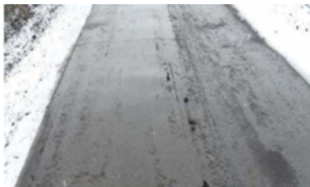
左レーン：坂道勾配の高い方から低い方に向かって舗設している。基本的には、低い方から高い方に向かって舗設すべきである。AFによる敷均し密度：坂を昇る方向の方が大きい。振動ローラ転圧：昇降切り替え時の振動を手動で切る事。（急激な停発進としない事）
