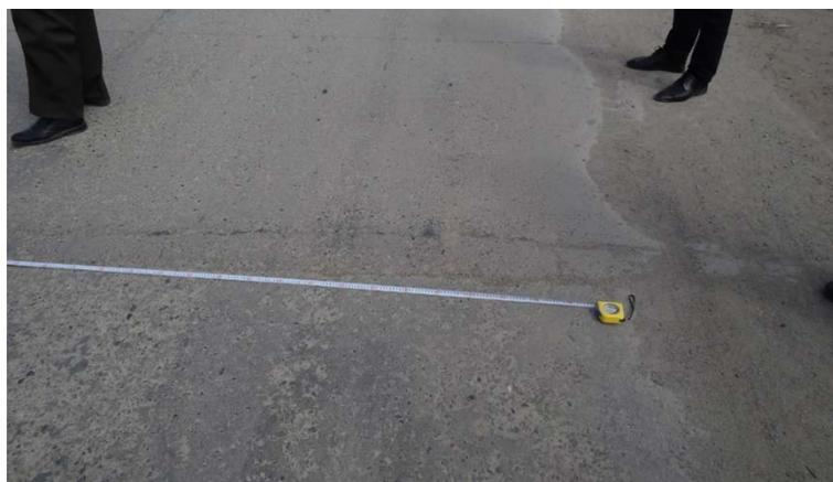
RCCのセメント硬化反応温度のピークを過ぎて収縮し始めた時期に、外気温が下がり始めて（朝方）、発生収縮応力が保有収縮強度を超えた時期に発生する。
