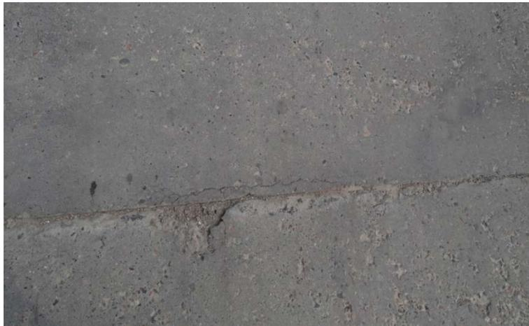
カッティング時期の早すぎ。舗装表面飛散に繋がる。カッター目地施工方法は、最初は1枚刃で切り、養生終了後2枚刃で切りなおす。なお、路盤の沈下・路盤支持力が少し低下している可能性もある。
