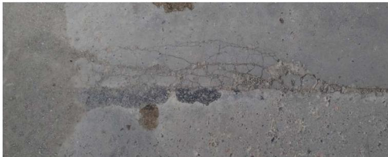
構造的に隅角部であり、応力が集中し、路盤支持力の低下（凍上、排水）の影響もあり、クラックが発生している。排水を確実にを行うとともに、凍上対策（凍上を起こしにくい材料）を行う事が大切。
