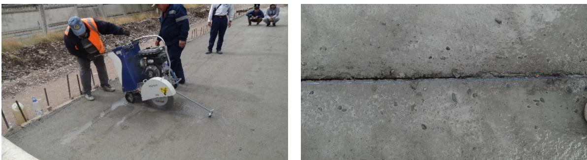
写真 10-15 ジョイントカットの実装
