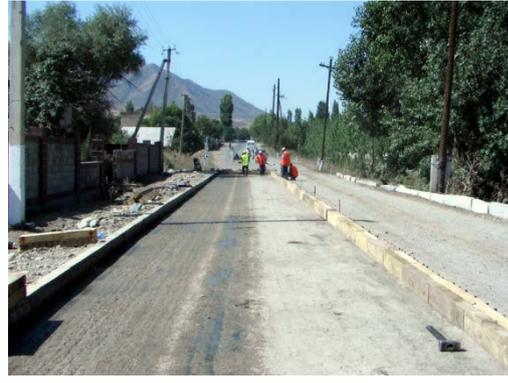
写真 10-6 2010 年 型枠設置状況
