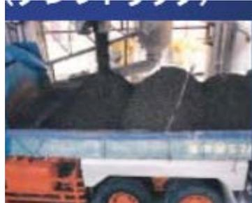
写真 10-2 ダンプトラックへのコンクリートの積み
