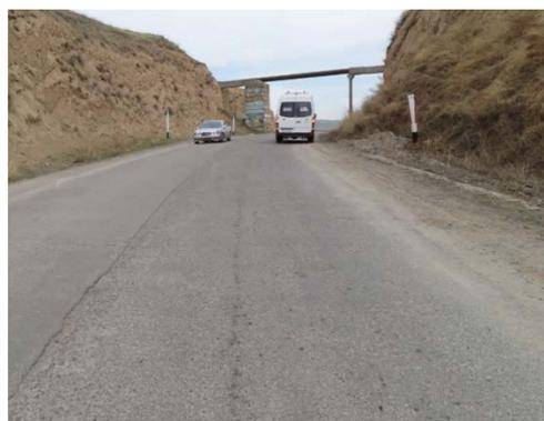
右側レーンは、仕上がり状況悪い（材料分離、コンシステンシー悪化）コンクリート製造プラントの故障（骨材送りベルトコンベア）により、RCCの品質不良が生じ、それを舗設してしまった。RCCの受け取り基準の明確化が必要。また、この部分は、スケーリング（表面の損耗）を生じている。RCCの水分過多、転圧方法未熟のより振動ローラ鉄輪に付着し、それが供用と共に、スケーリングとなっている。
