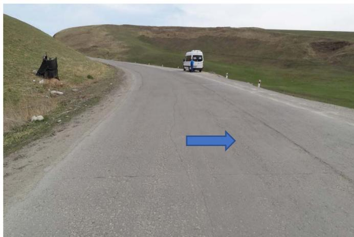
拡幅部・下り内カーブ部に発生した構造的縦ひび割れ。路盤支持力低下（凍上）し、幅員大・内カーブなので曲げ応力が過大となった。凍上対策が重要である（凍結深度まで凍上しに
