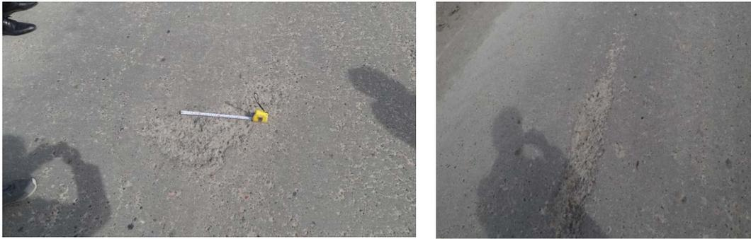
RCCのコンシステンシー不良、舗設時にRCCがローラに付着した。コンシステンシー把握、ローラの哲倫ロール面を何時も綺麗にしておく事が肝要。
