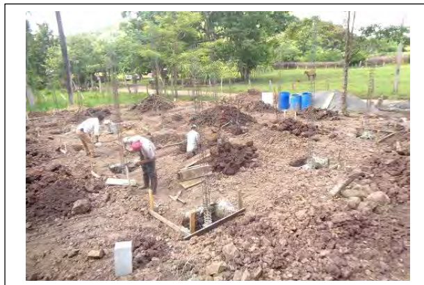
SILAIIS チョンタレス アコヤパ支所エル・チナル保健セクター 新しい保健ポストの建設が始まっている
