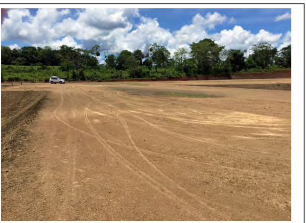
ヌエバ・ギネア病院建設予定地 整地された建設予定地。
