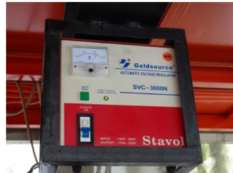
電圧レギュレータ
