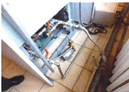
高圧蒸気滅菌器 (送水ポンプ破損)
