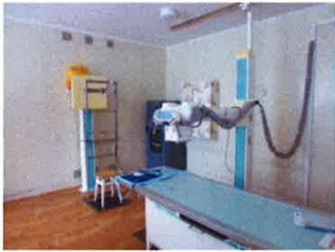
位置決め装置、ジェネレーター不良
