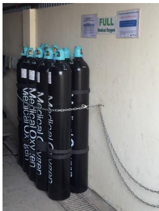
写真 3.5 転倒防止柵がなされ看板もある状態
