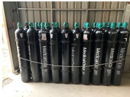
写真 3.6 看板が落ちており転倒防止柵が緩んでいる
