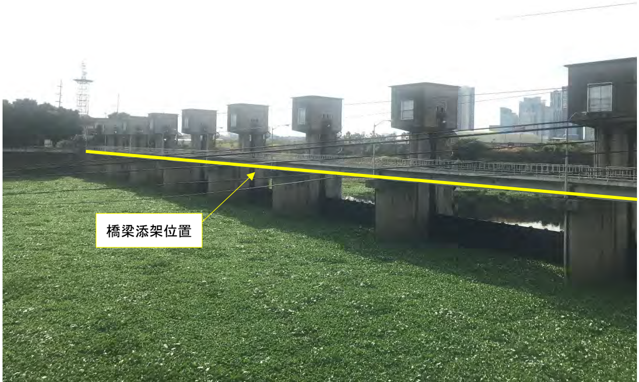
図 7.3.135 区間3への敷設ルート（ROSARIO 堰管理橋 橋梁添架）
