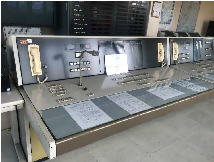
図 7.3.122 Rosario 堰警報設備の既設操作卓
