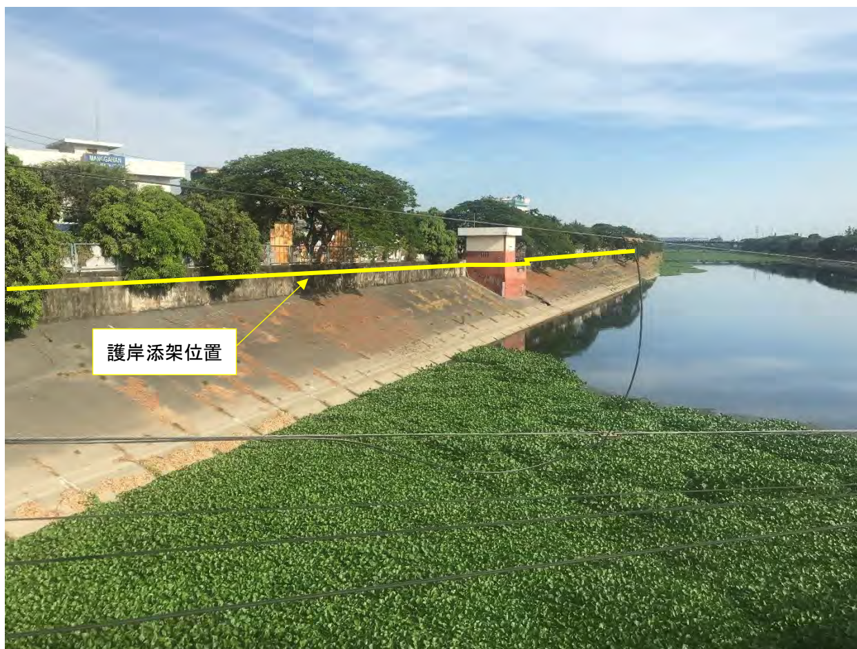
図 7.3.136 区間4への敷設ルート（護岸添架）
