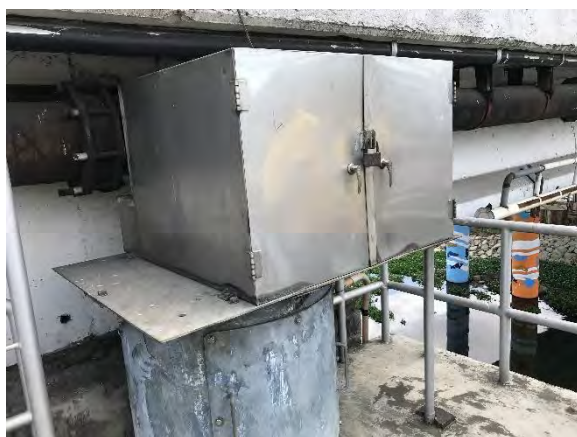
図 7.3.106 フロート式水位計設置例（日本）
