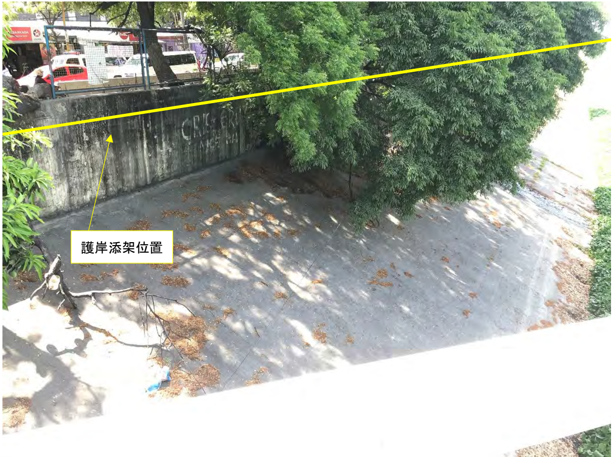
図 7.3.137 区間 4 への敷設ルート（護岸添架）
