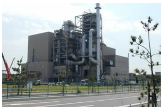
東京 23 区中防破碎ごみ処理施設 (プラント設備を屋外に設置)
