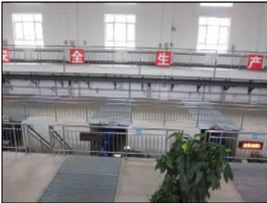
第5浄水場(ポンプ場)
