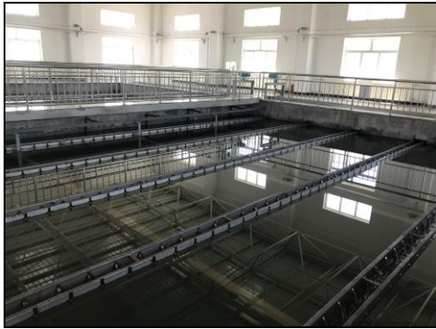
本事業で整備された恵農区浄水場
