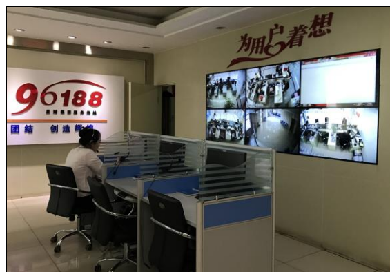
実施機関中央制御室(石嘴山市)
