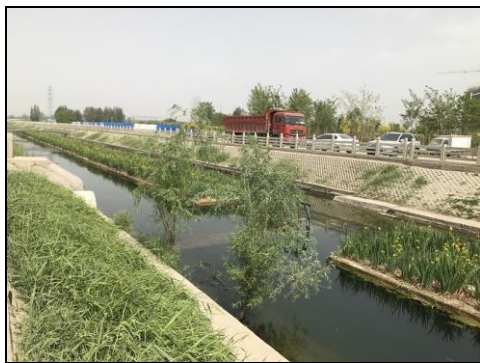
本事業で整備された処理場近郊の用水路 (銀川市)
