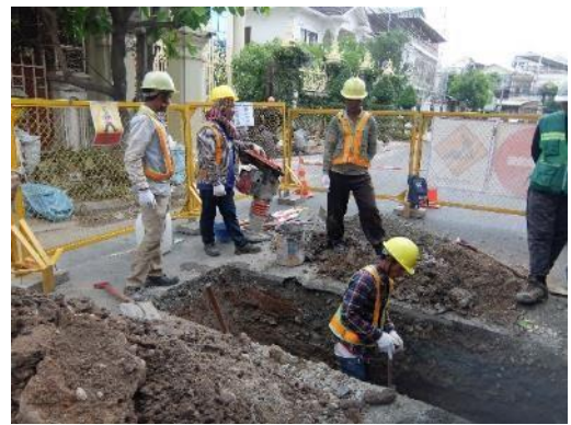
雨水管の工事現場- 2
