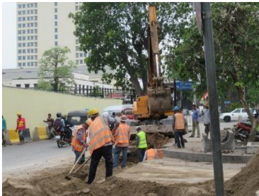
雨水管の工事現場- 1
