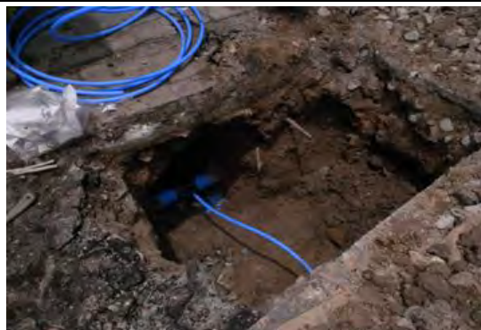
SABESP、Butanta 地域の漏水対策、管路置き換え作業、現場視察
