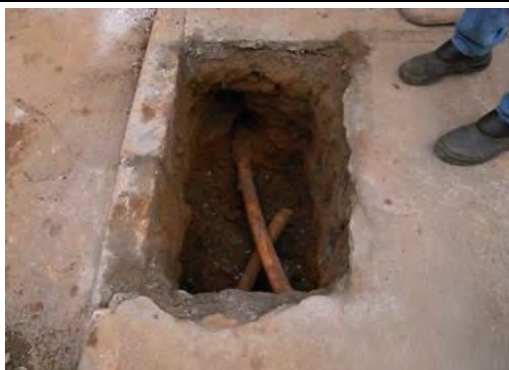
COMGAS、Tatuape 地域のガス管の拡張作業、現場視察
