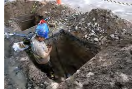
水道管のバルブ箇所の工事
