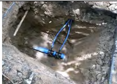
水道管の本線と支線。切断された古い管も確認する
