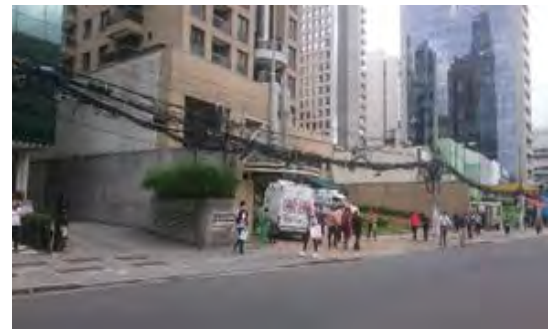
写真：Vila Olimpia 電線配線の状況
