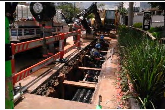
ENEL、Barueri 地域の電線地中化、現場視察
