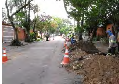
工事現場の風景。この地区の街路樹は保護対象のため伐採することはできない。そのため、歩道から中央よりに管路を通して
