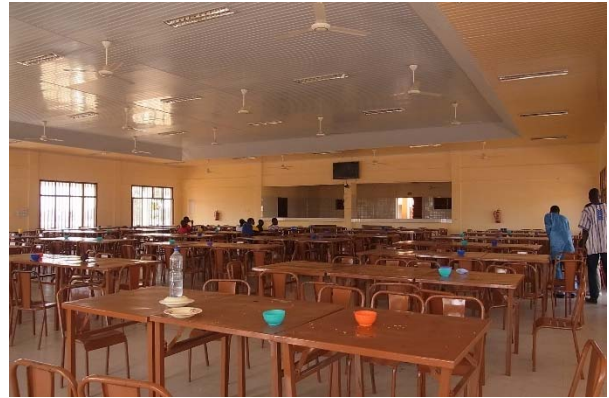
写真7. 類似校（ENEPテンコドゴ）：食堂 奨学生（寮生）が利用する食堂。厨房の熱源にはガ スを使用している。本計画で消防に指導を受けた、 排煙設備は未整備。
