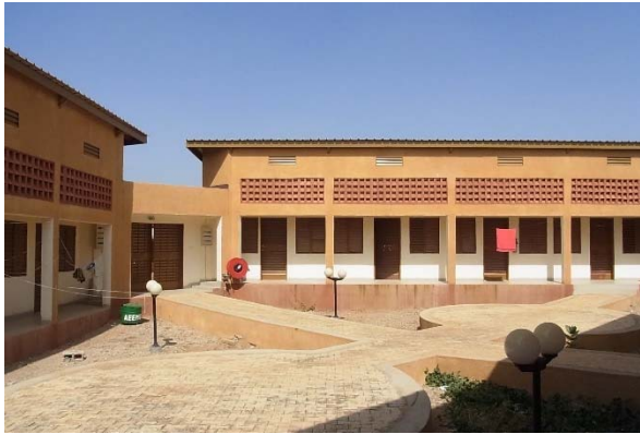
写真6. 類似校（ENEPテンコドゴ）：学生寮 定員60名の学生寮が7棟整備されている。ENEPフ ァダ・ングルマと同じ設計であり、平面形状は中 庭を囲んだ三角形。
