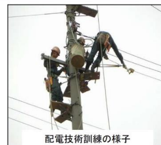
配電技術訓練の様子
