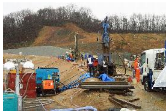
写真 11 飯坂クリーンサイト地中熱方式融雪ボーリングの掘削現場
