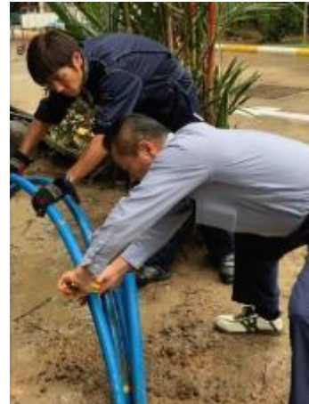
写真7 Well-1 熱交換器挿入
