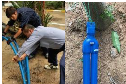
Well-1 熱交換器挿入
