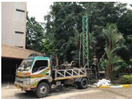
写真 3 ボーリング実施状況
