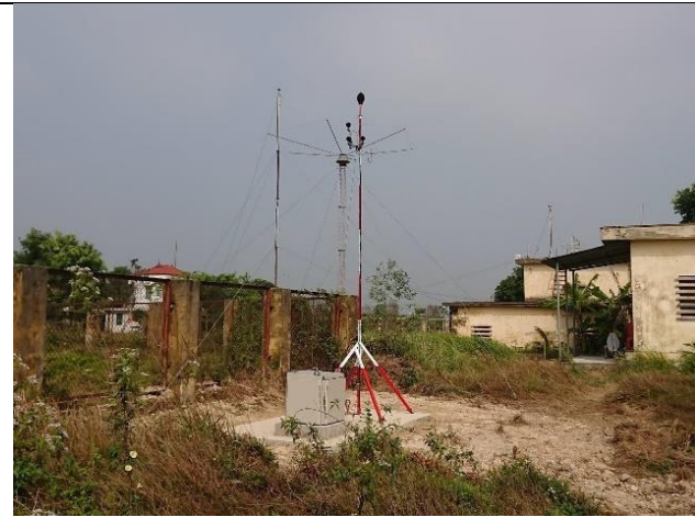
航空機騒音監視装置設置
