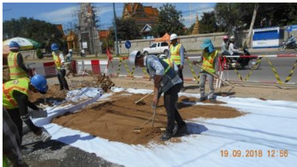
2018年9月 (DPWT 入口施工時)
