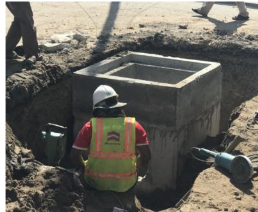
2018年11月 (カンダールマーケットマンホール施工)
