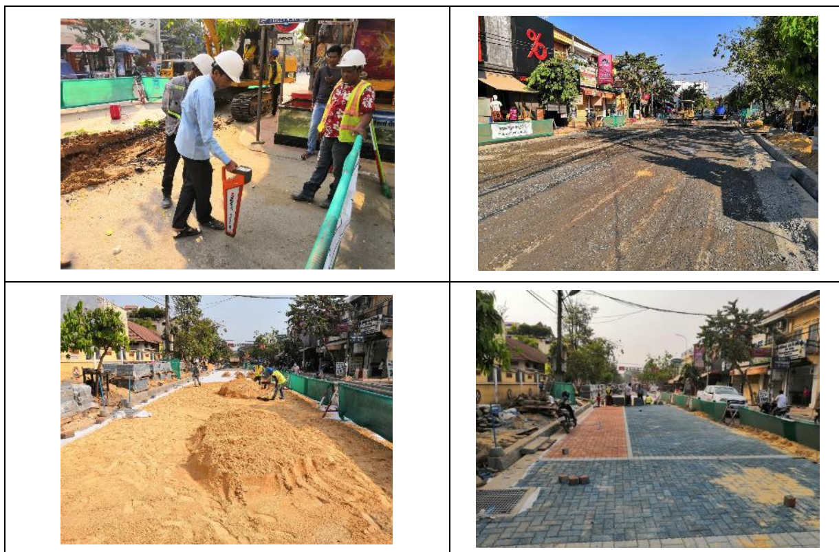
図 3-19 SR 州病院前、St.8 の施工状況
