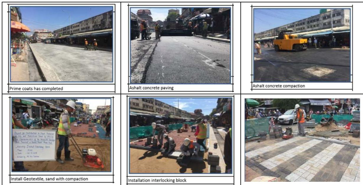
図 3-17 PP 都カンダールマーケットの施工状況
