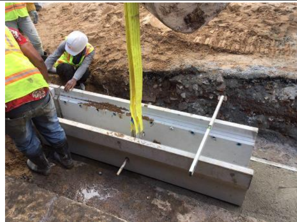
2018年11月 (カンダールマーケット側溝施工)
