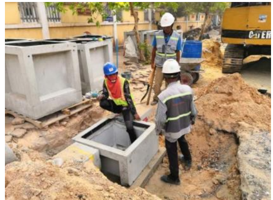
2019年3月（SR州病院前マンホール施工）
