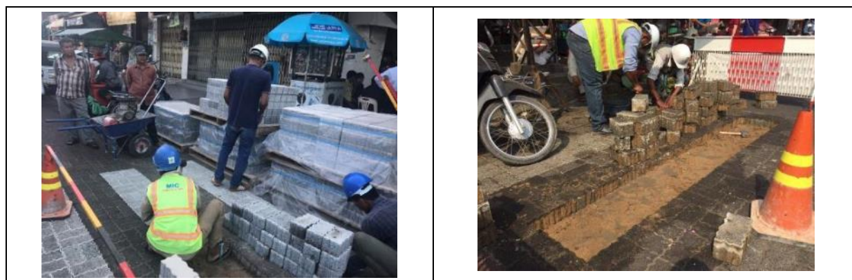
図 3-25 シリカ剤添付の ILB への取り換え施工 (PP 都カンダールマーケット 2019 年 1 月)
