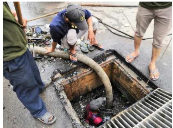
2018年11月（カンダールマーケットマンホール清掃）
