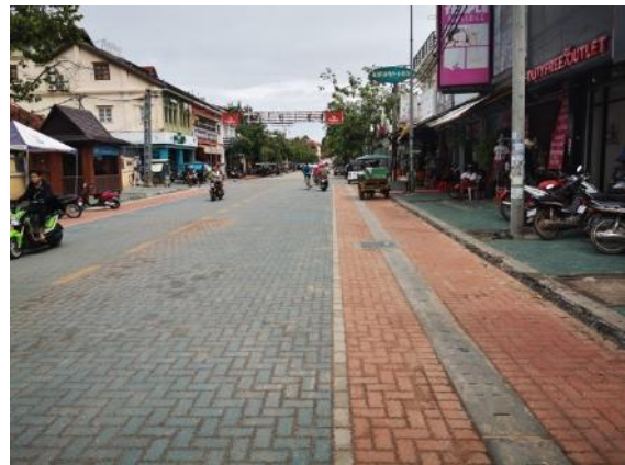
2019年5月 (SR州病院前施工後)
