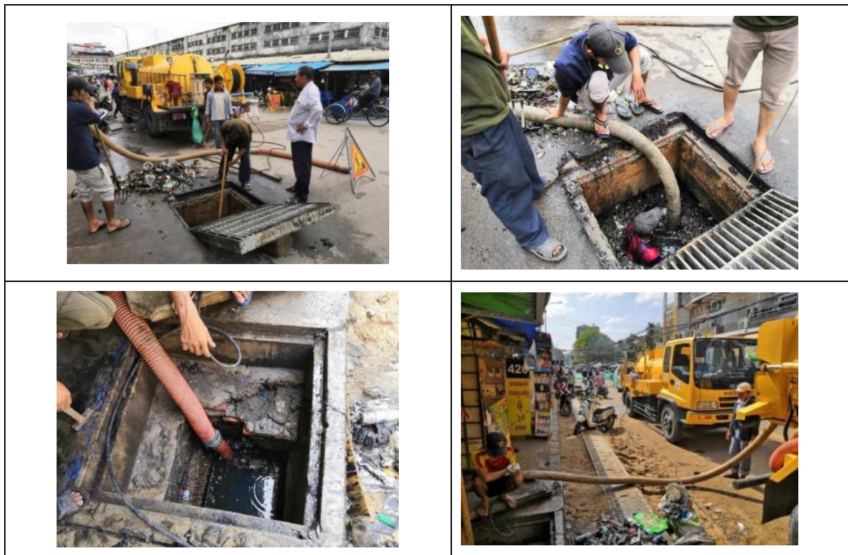
図 3-18 PP 都カンダールマーケット既存排水管の清掃
