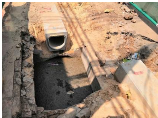
2019年3月（SR州病院前側溝の施工）
