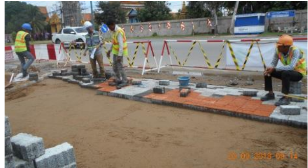
2018年9月 (DPWT 入口施工時)
