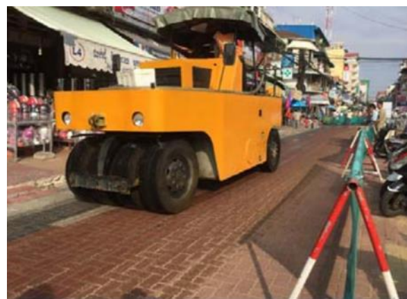
2018年12月 (カンダールマーケット施工時)
