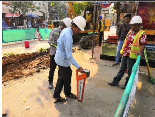
2019年3月 (SR州病院前地下埋設物探査)
