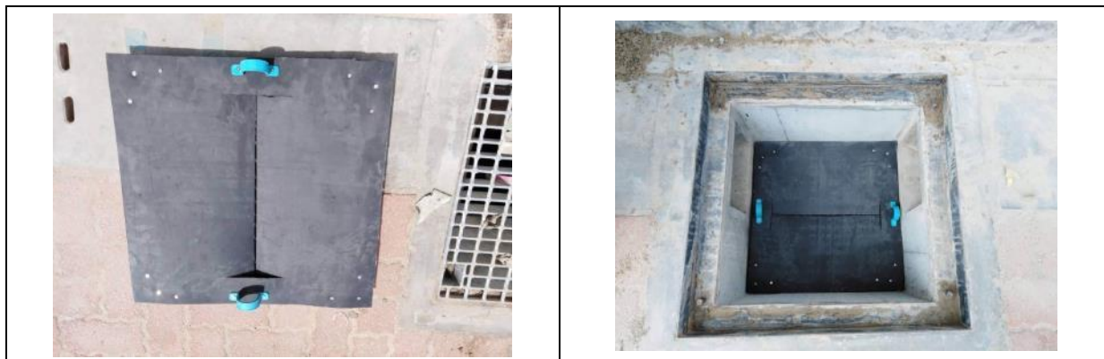
図 3-26 グレーチング中蓋の設置（SR 州 病院前）
