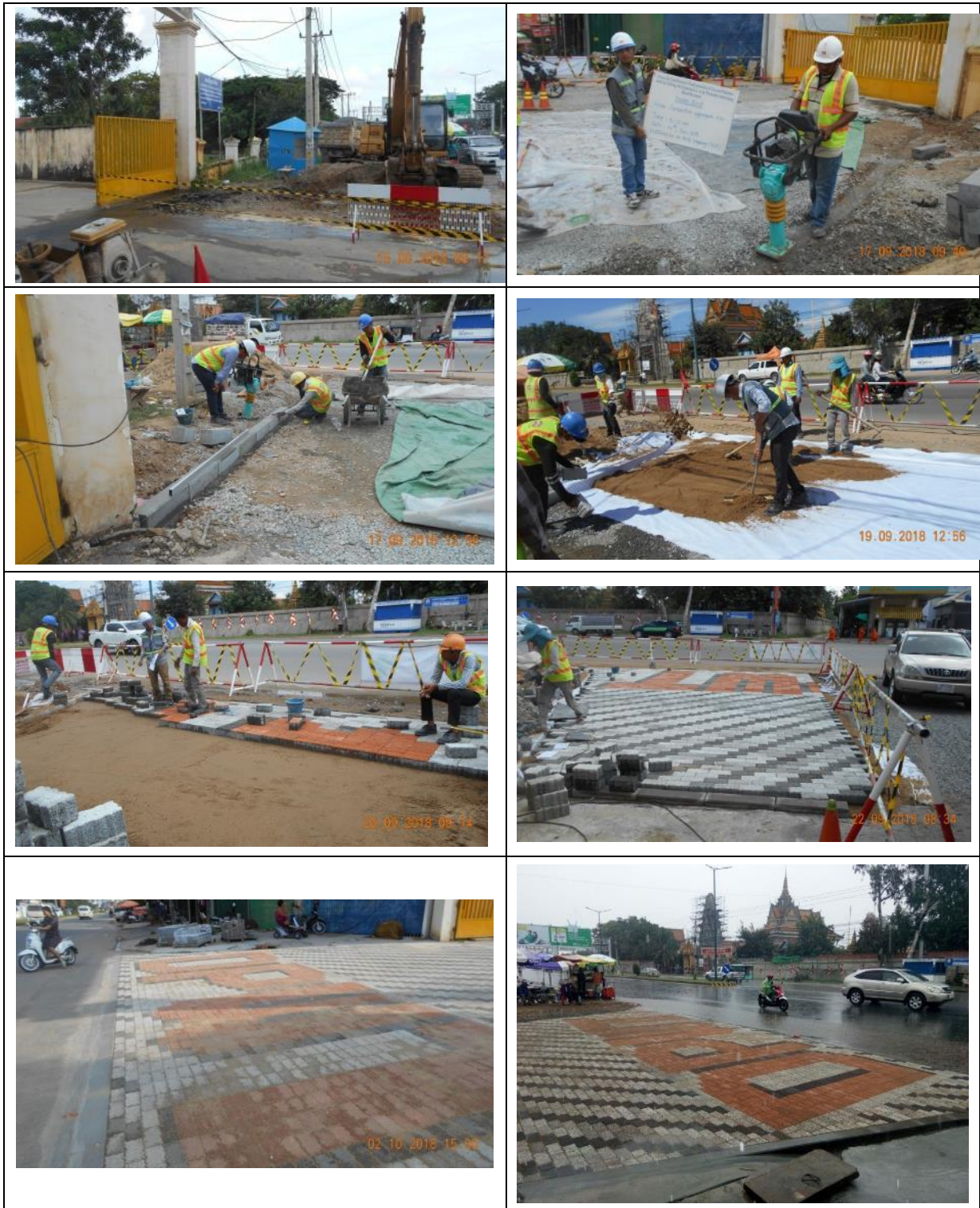
図 3-14 PP 都 DPWT 入口の施工状況
