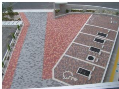
（左）インターロッキングブロック（ILB）施工例 “水たまりが出来ず、雨が降っても滑らない”
