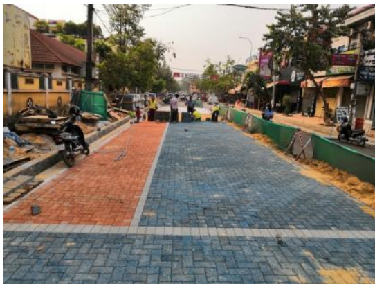
2019年5月 (SR州病院前ILB施工状況)
