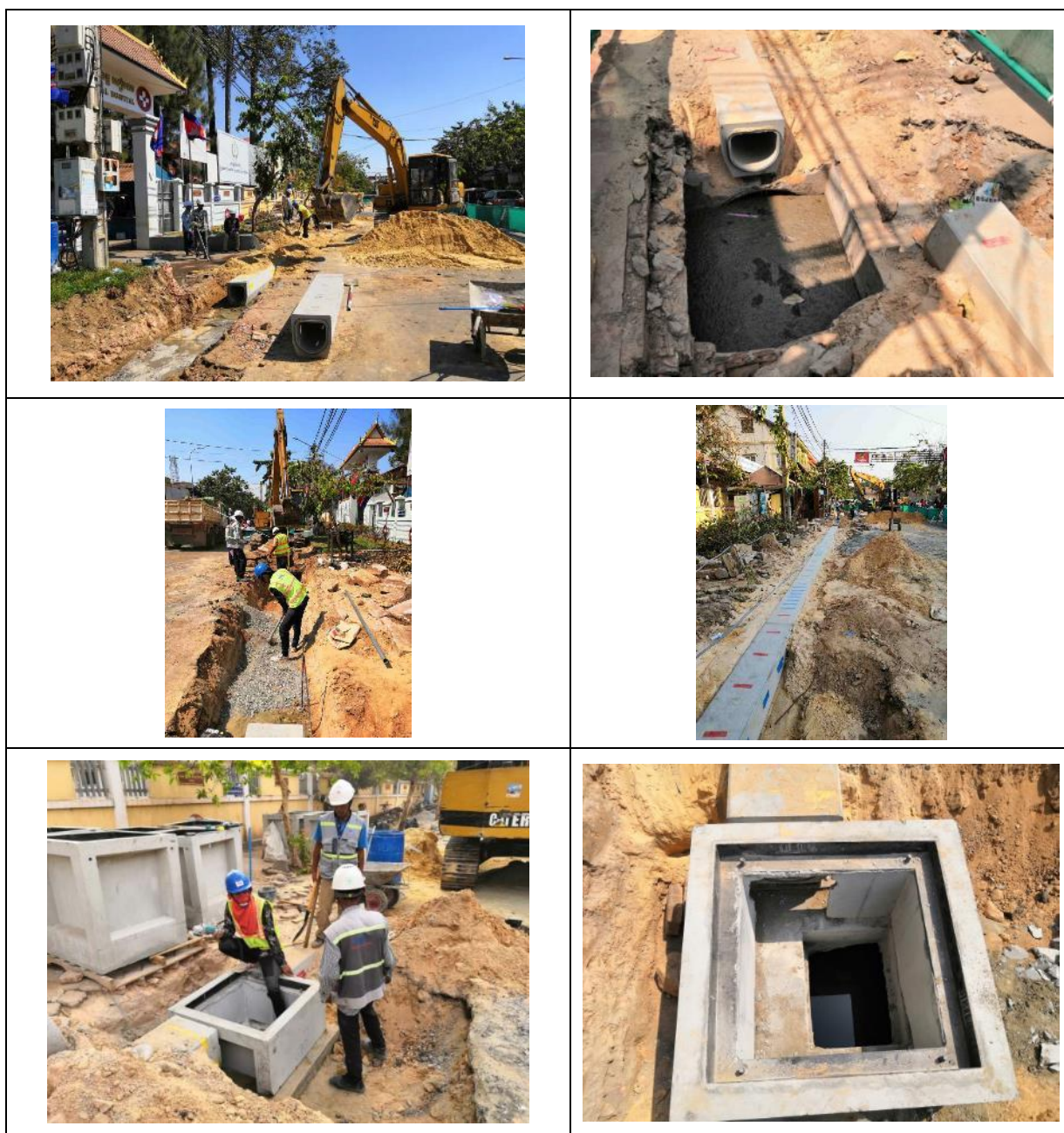
図 3-19 SR 州病院前、St.8 の施工状況
