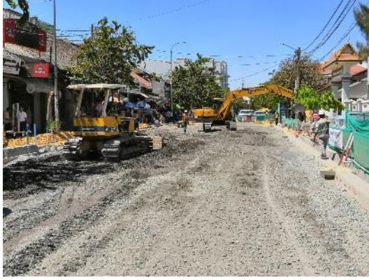
2019年3月 (SR州病院前路盤の施工)
