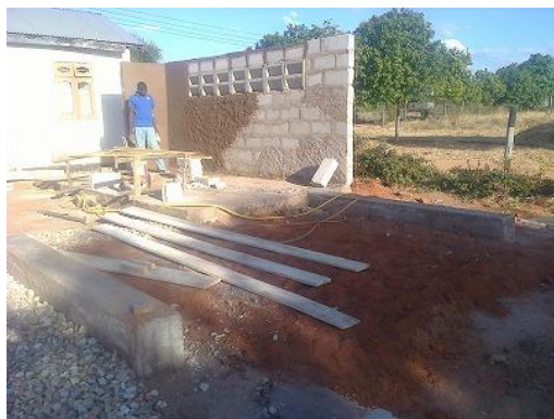
写真 9: 20FT コンテナ型糖化・貯蔵庫設置用基礎工事
