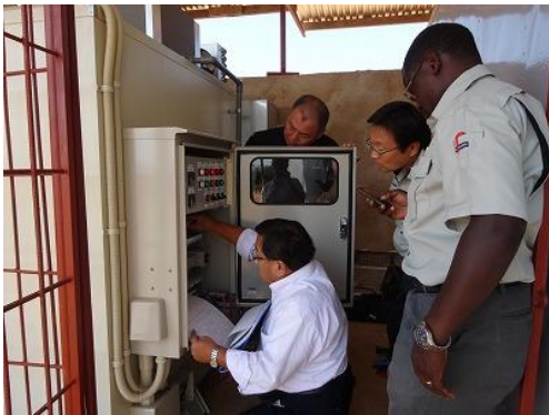
写真 27: 1.5 坪型糖化・貯蔵庫の試運転調整 (2017 年 8 月)
