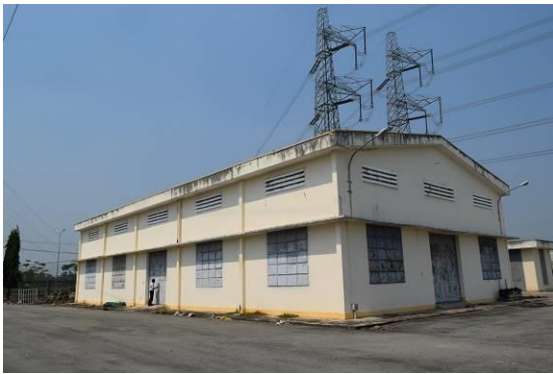
ロンアン省堆肥センター候補地
