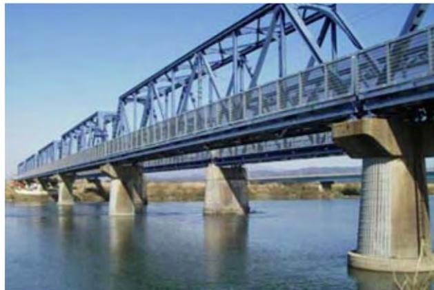
図 6-23 防風柵（パンチングメタル）の設置（羽越本線 砂越～北余目間 出典：『JR 東日本 安全報告書 2014』）
