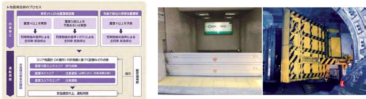
図 6-24 同社の地震対策フロー図（左） 浸水対策の止水板（中） 防水ゲート（右）
