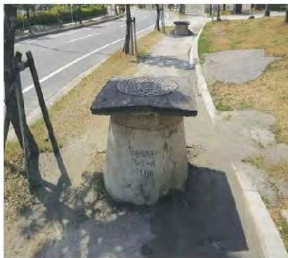
図 6-78 地震による液状化により浮上したマンホール(出典:堀井美和)
