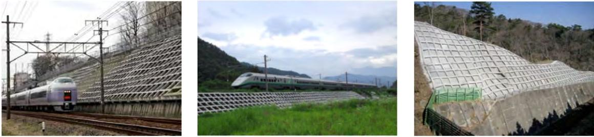
図 6-22 土砂災害対策のための吹付砕工（左から切取法面工（中央本線）、盛土法面工（山形新幹線）、自然斜面防護工。出典：『JR 東日本 安全報告書 2014』）
