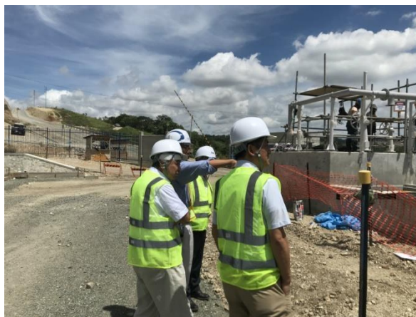
Joyce Bay STP 建設状況視察
