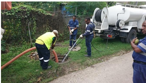
管渠維持管理トレーニング
