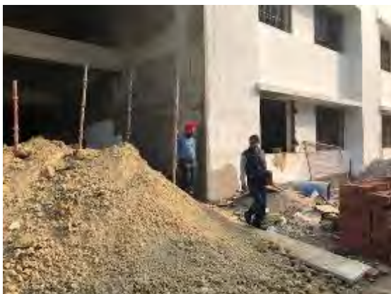
本事業にて新たに導入する機械設置をする 建物(建設中)(2018年12月4日)
