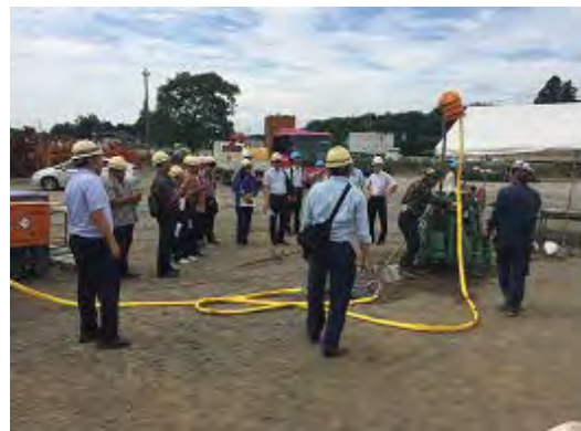
7月11日 見学会（日特建設猿島総合センター） 注入装置の説明
