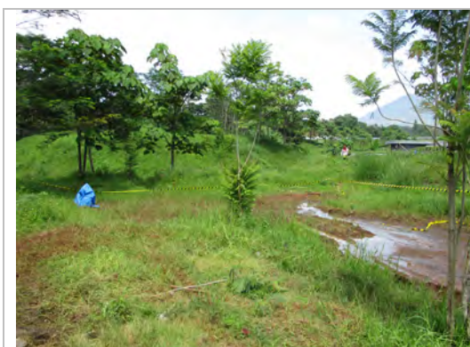
施工箇所全景
