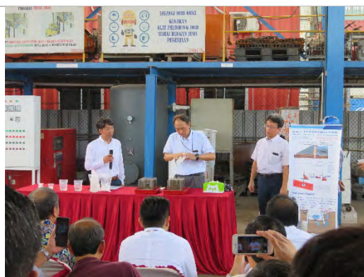
簡易注入試験状況 (砂地盤への注入状況)
