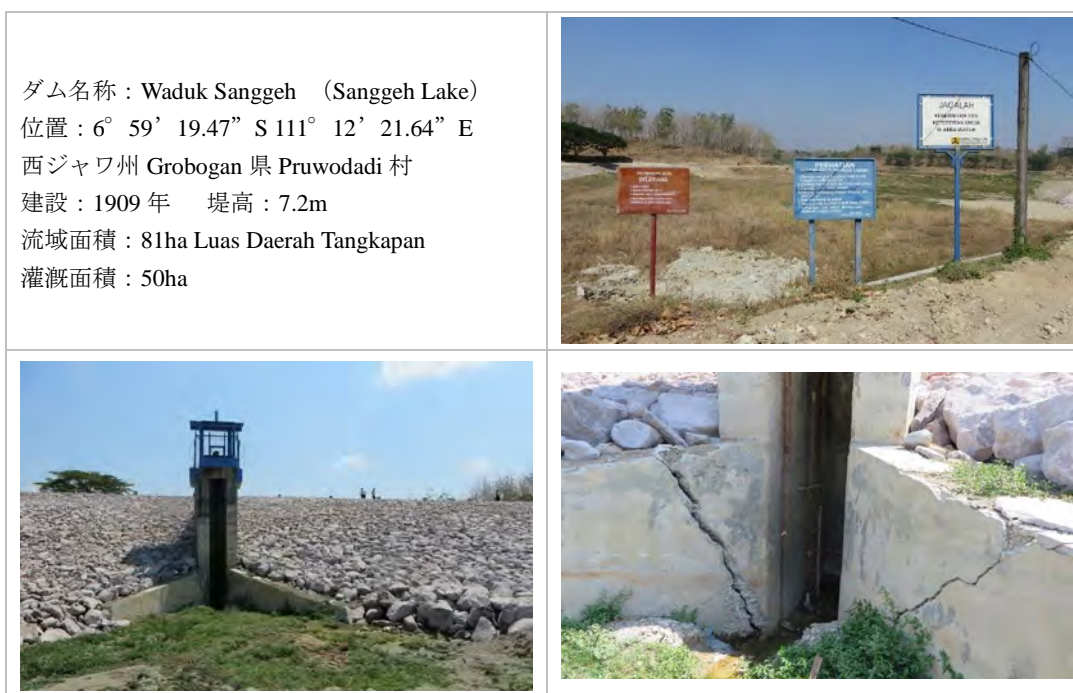
写真 2 既存技術による老朽化ダムの補修状況
