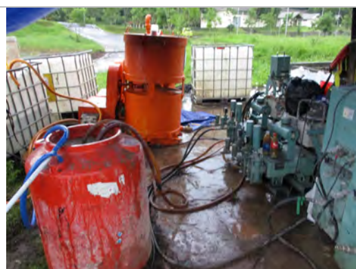
プラント仮設状況
