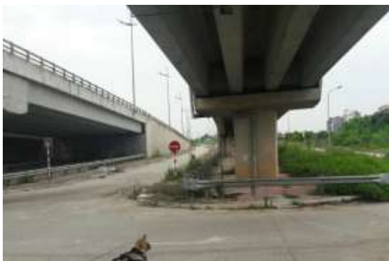
Vị trí giao đường Vành đai 3
