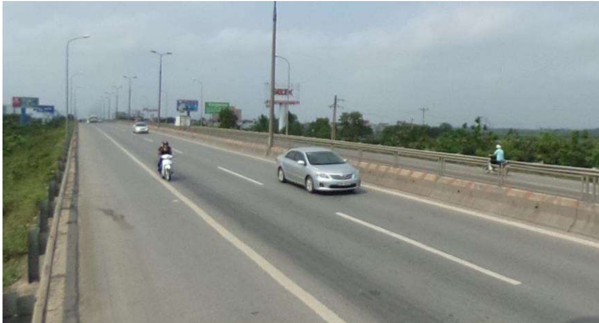
Hình 16-2. Hiện trạng tuyến đường Võ Văn Kiệt
