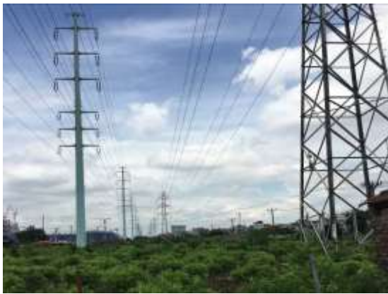
Vị trí giao đường điện cao thế 110kV (khu đô thị Ciputra)
