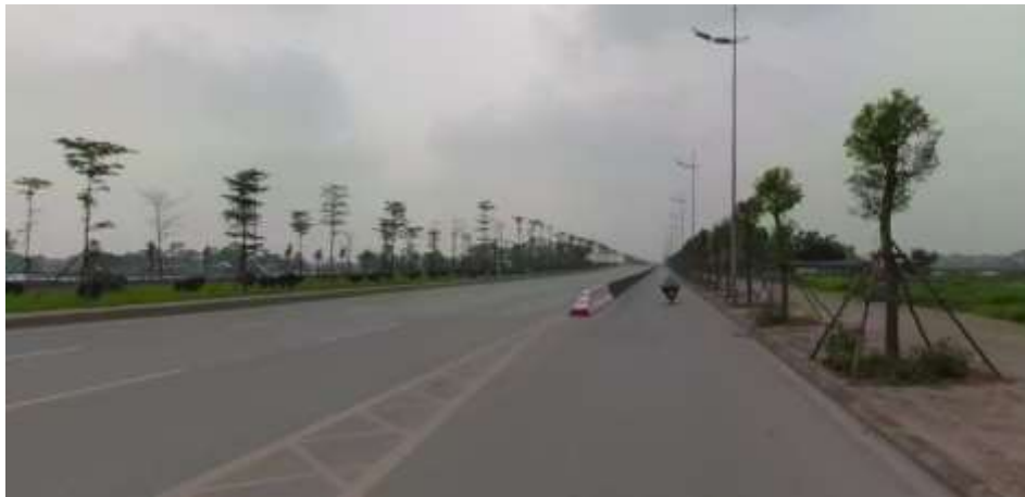
Hình 16-11. Hiện trạng đường Quốc lộ 5 kéo dài (đường Hoàng Sa)
