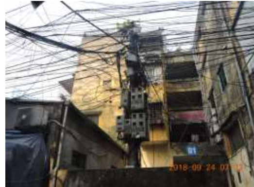
Hệ thống dây phân phối hạ thế và đồng hồ đo treo chằng chịt trên cao
