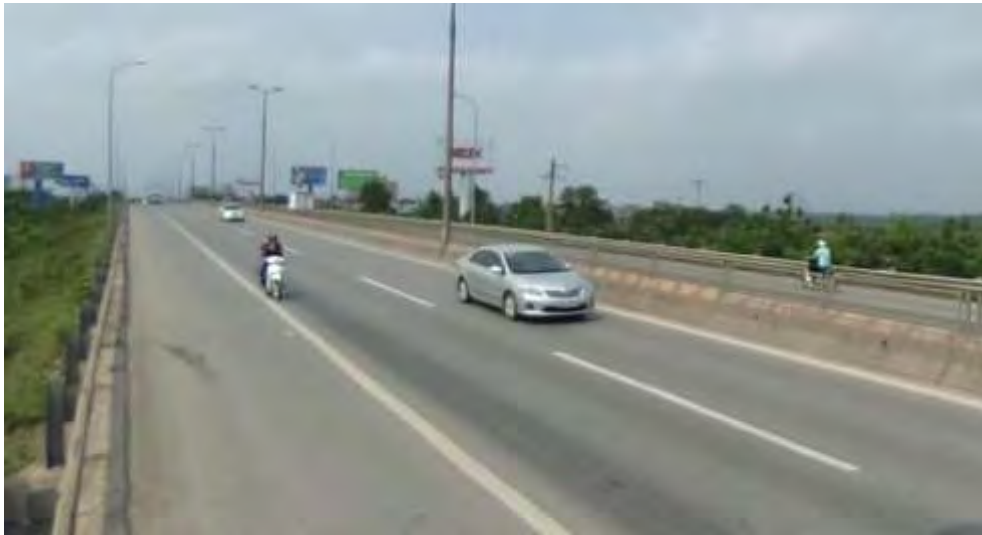
Figure 16-2. Existing Vo Van Kiet Road
