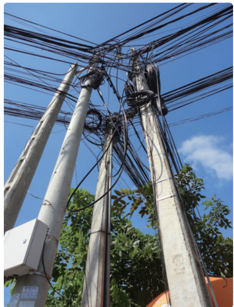
ローカルアクセスケーブル(架空線)
