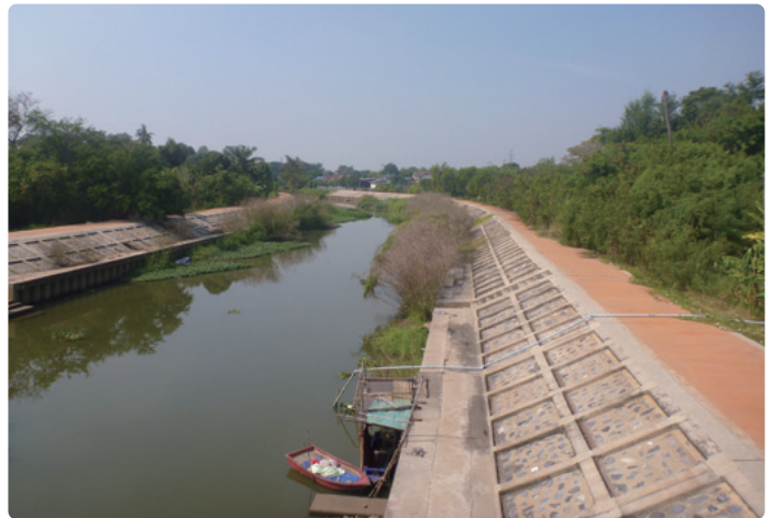
タイ「パサク川東部アユタヤ地区洪水対策計画」本事業で整備されたハントラ水路の護岸
