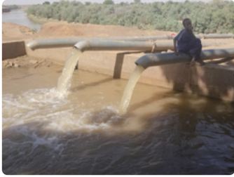
ソマリ州で建設された灌漑施設
