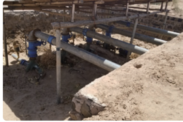
ソマリ州で建設された灌漑施設2
