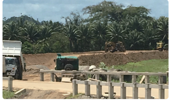
工事中のプラオ地区幹線道路
