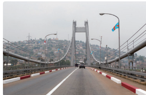
送気乾燥システムが設置されたケーブル。前方はマタディの街 撮影者：久野真一
