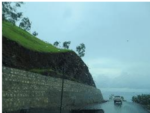
東ティモール北部 (国道 1 号線 : Hera～Dili 方面)
