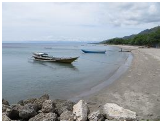
突堤付近の海岸線の状況（南側）
