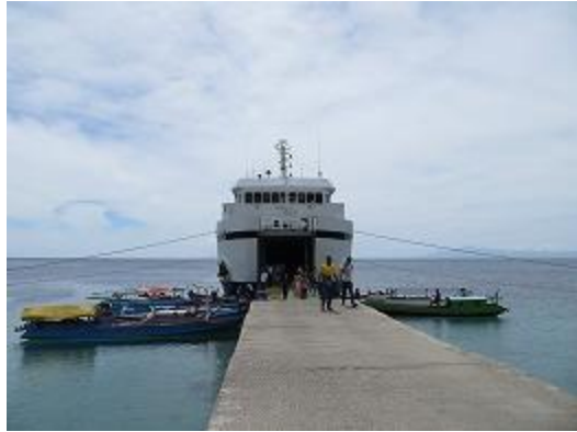
フェリー着岸用突堤
