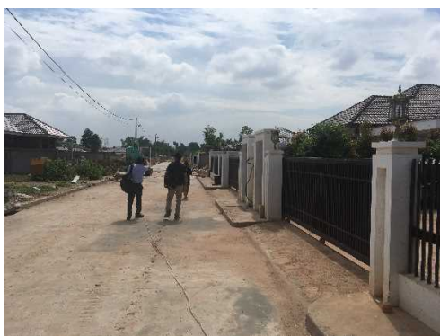
住宅建設現場視察 2019 年 5 月
