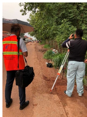
デモ工事（測量） 2019 年 7 月
