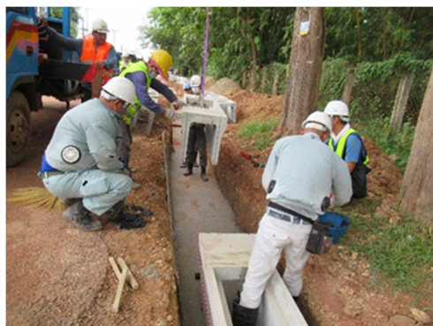
デモ工事 2019 年 9 月
