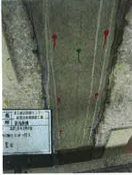
Ankraj uygulanacak yerlerin belirlenmesi
