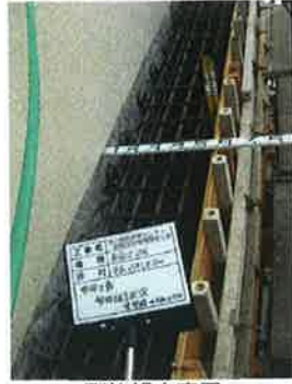
型枠組立完了
