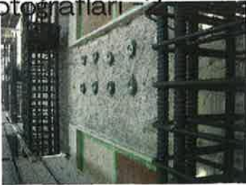
Disk-Ankraj (montaj sonrası)
