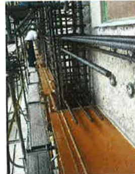
Kiriş donatılarının montajı
