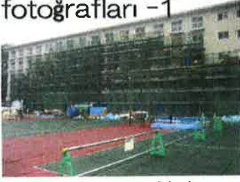
İskele Kurulumu (Yatılı bina)
