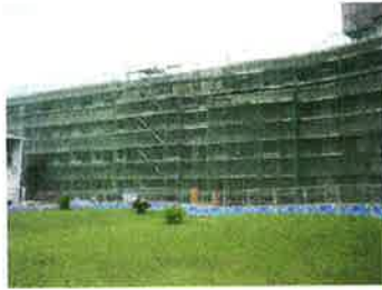
外部足場組立(本館棟)
