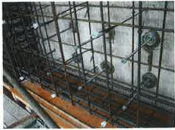
アンカー筋挿入
