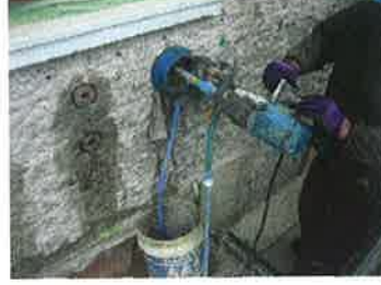
Disk-Ankraj için karot uygulaması
