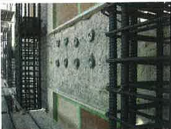
ディスクアンカー定着完了
