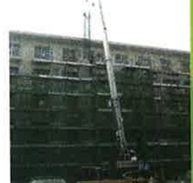
柱筋吊込み
