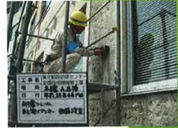
既存躯体鉄筋探査
