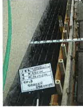
Kalıp işleminin tamamlanması
