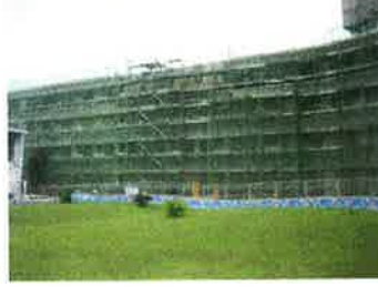
İskele Kurulumu (Ana bina)
