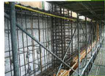
梁筋組立完了
