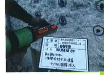
Disk-Ankraj' ların montajı
