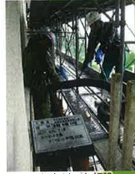
コンクリート打設
