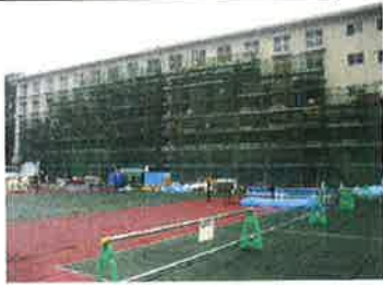
外部足場組立(寄宿舎棟)
