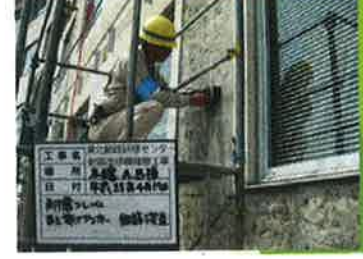
Mevcut yapıdaki donatı yerlerinin belirlenmesi
