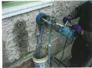
ディスクアンカー削孔
