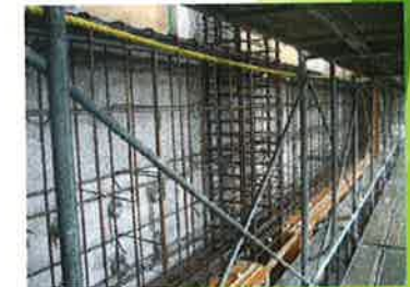
Kiriş donatılarının montajı (tamamlanmış)
