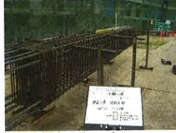
Kolon donatılarının hazırlanması
