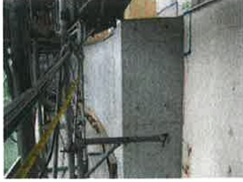
Kalıpların sökülmesi
