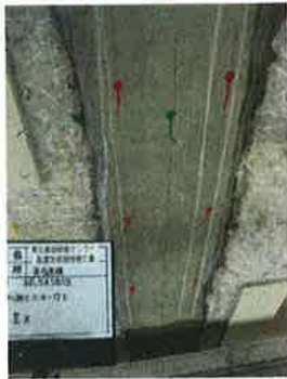
アンカー位置墨出し
