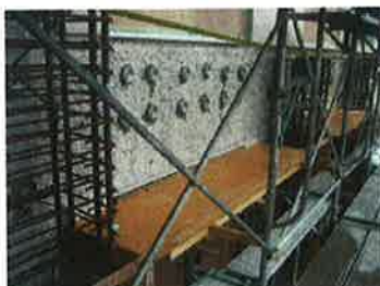
型枠建込(梁底)
