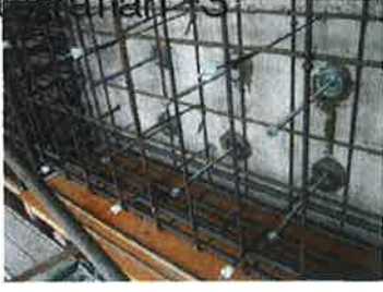
Disk-Ankraj tiplerinin motajı (vidalanması)
