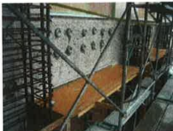
Kalıbın yerleştirilmesi (kiriş altı)
