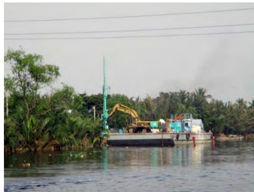
写真 20 実証試験状況
