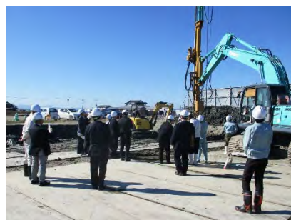
写真 19 施工管理手法の研修
