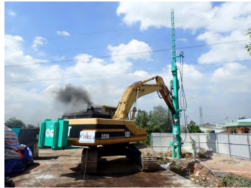
実証試験 試験施工状況
