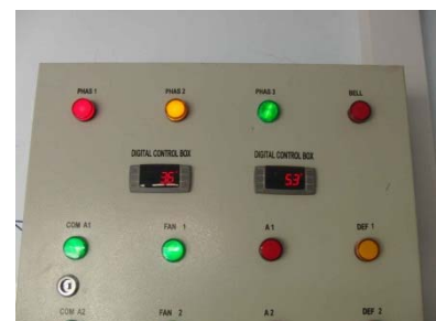
Hình 10-3 Bảng điều khiển quản lý nhiệt độ kho chứa chất thải
