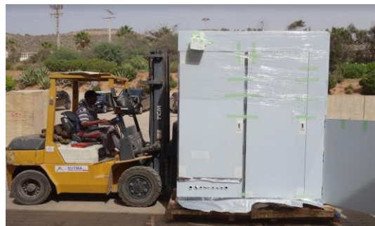
搬入作業の様子
