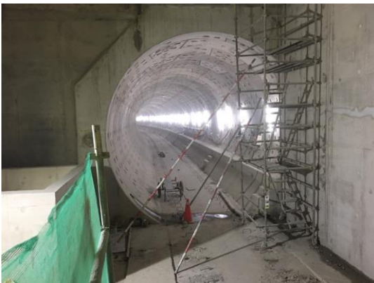
写真-7 地下鉄建設現場の視察 (ホーチミン) (2019年9月27日)
