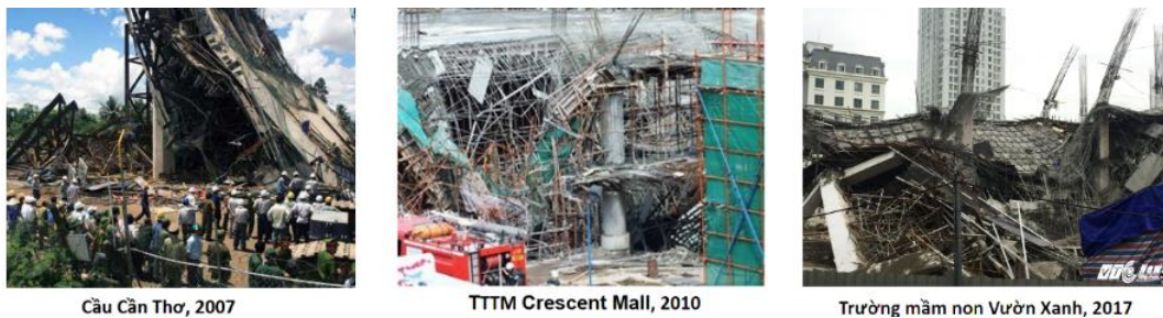
写真-2.1 近年のベトナムでのインフラ建設中の事故、左写真は2007年に発生したカントー橋崩落事故の事例 (資料提供：MOCのSACQI建設品質検査当局)
