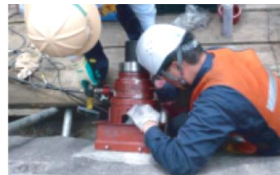
写真-3.2 計測サービス (アンカー荷重計の設置状況)
