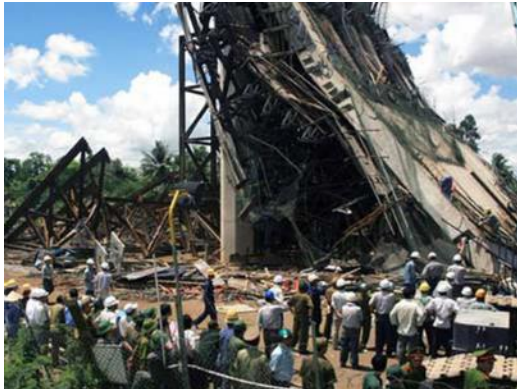
写真-11 ベトナムでの事故例(カントー橋, 2007) (2019年11月26日、提供:MOC)
