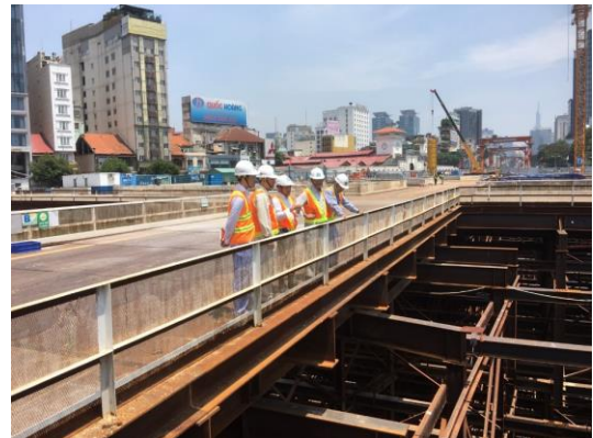
写真-6 大規模掘削現場の視察 (ホーチミン) (2019年9月27日)
