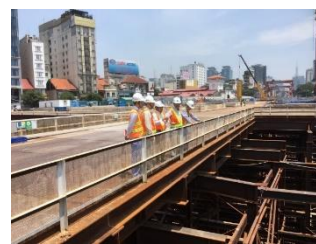
写真-2.2 ホーチミン市・地下鉄工事現場（調査団撮影）
