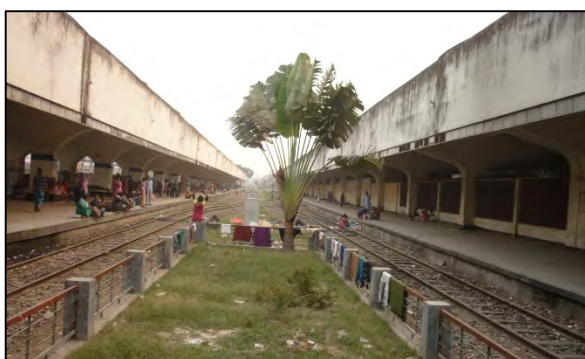
パイロット事業対象のダッカ駅（Kamalapur）
