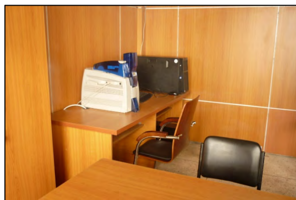
DTCA のサーバ室に設置された PTO サーバ
