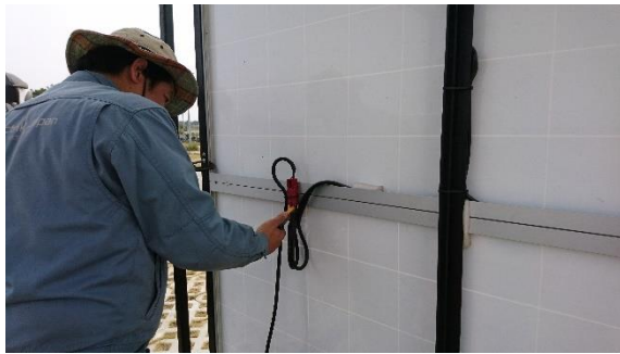
ソーラーパネル取り付け作業
