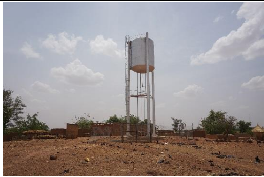
5. 現在稼働中の高架タンク
