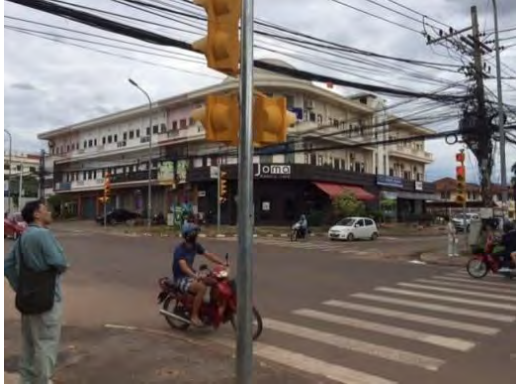
13. 既設信号機の視察
