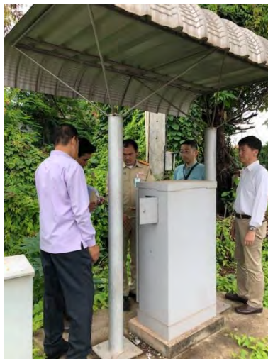
15. 既設信号機の視察
