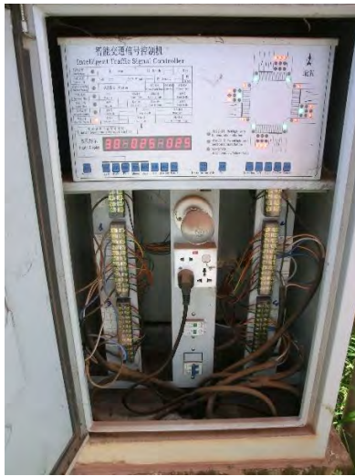
制御機内部の様子 3 (中国製)
