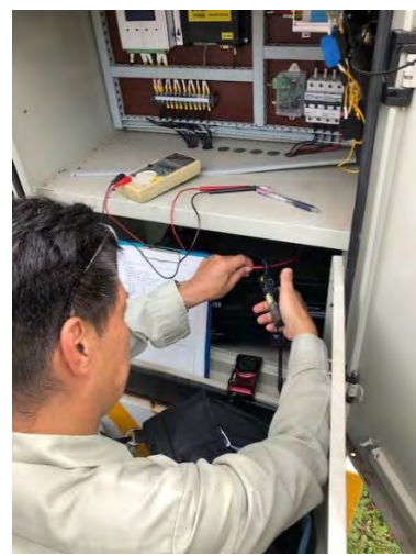
16. 既設信号機の視察
