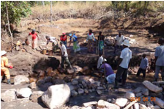
Kapanda 恒久堰 建設現場 (北部州 Kasama 郡)
