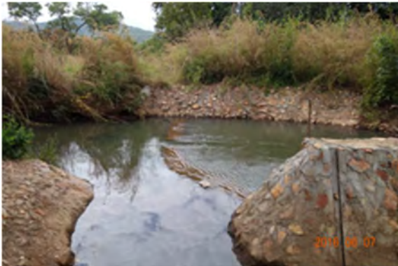
Lualizi 恒久堰(水路掘削中) (ムチンガ州 Isoka 郡)
