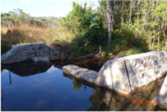
Mpela 恒久堰 (北部州 Mporokoso 郡)
