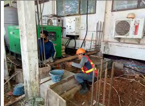
RRC 研究室設備の拡張工事
